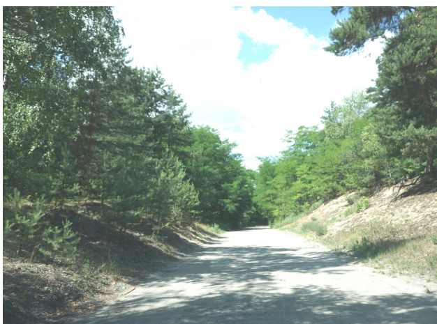
Droga biegnąca przez wydmy w południowo-wschodniej części obszaru planu
